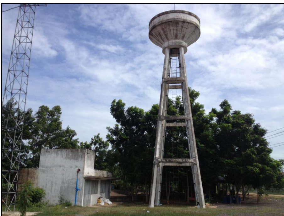
รูปที่ 2.6 ระบบประปาผิวดิน บ้านไพล หมู่ที่ 12
