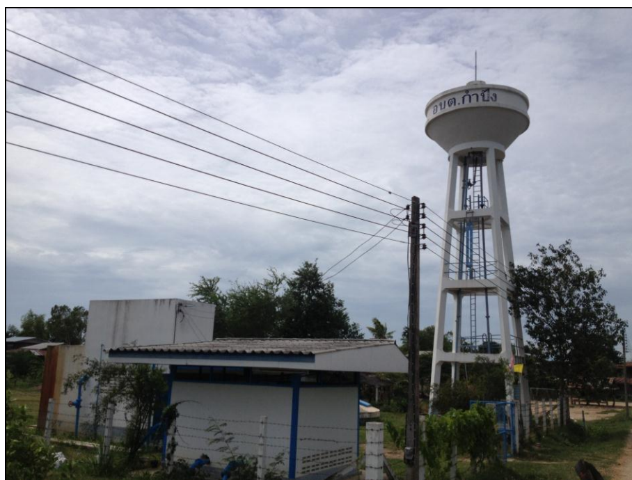
รูปที่ 2.4 ระบบประปาผิวดิน บ้านใหม่นารี หมู่ที่ 9
